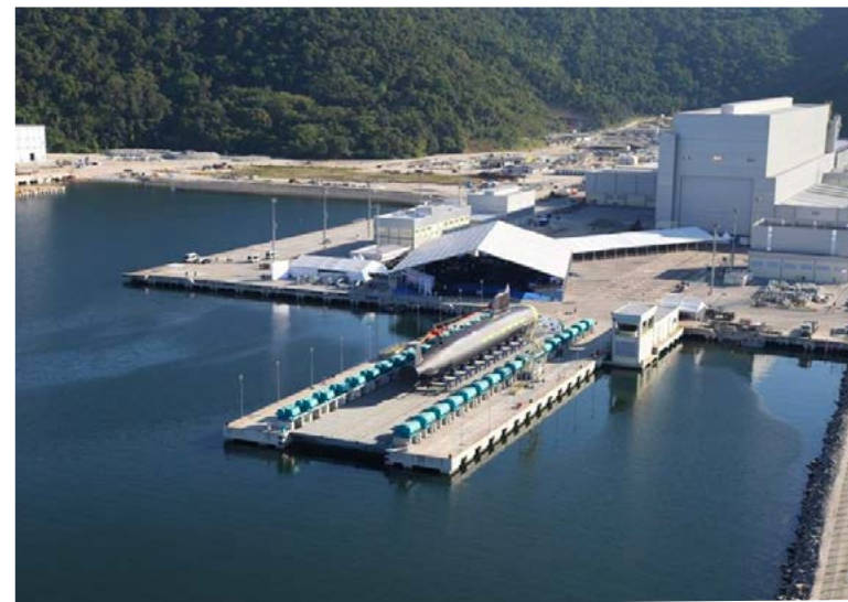
Complexe naval à Itaguaí au Brésil, construit avec l'assistance technique de Naval Group. La société Itaguaí Construções Navais, chargée de la construction des sous-marins Scorpène Brésil est détenue à 41% par Naval Group.
